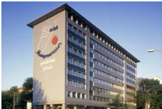
Modernität: Die zeitlose Fassade bestimmt das Bild des bekannten Margonhauses in Dresden.
