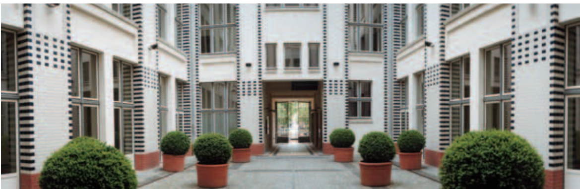
Zentralität: Das Haus zur Berolina, der Firmensitz der TLG IMMOBILIEN, liegt am Hausvogteiplatz, dem ehemaligen Zentrum der Textilindustrie inmitten der Hauptstadt Berlin.
