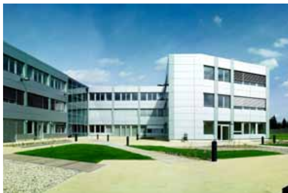
Innovation: Im hochmodernen Firmengebäude in Bautzen-Salzenforst entwickelt die Firma Sphairon Netzwerktechnologie.
