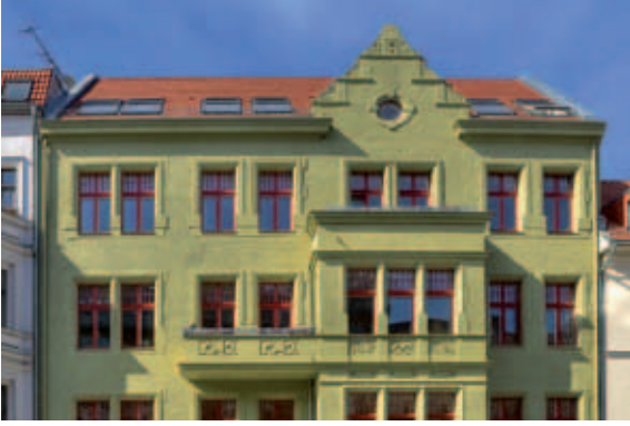
Urbanität: In Berlin-Mitte bieten die historischen Wohngebäude in der Max-Beer-Straße eine gute Bausubstanz.
